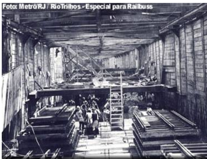
Figura 7: Operários na construção do Metrô, no Jardim da Glória em 1975
