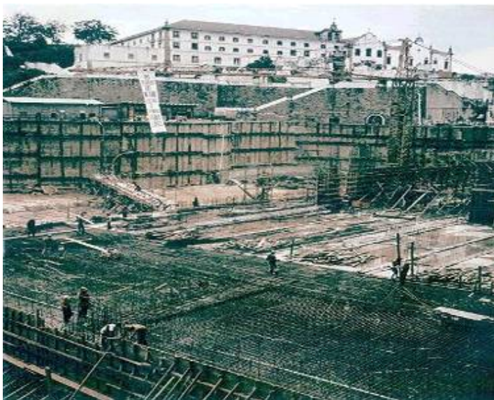
Figura 9: Largo da Carioca durante as obras da Estação Carioca em 1976
