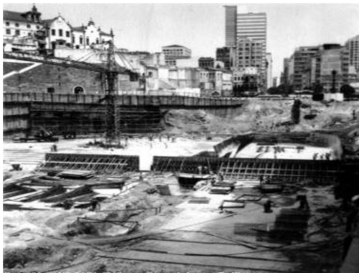
Figura 8: Largo da Carioca durante as obras da Estação Carioca em 1976
